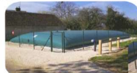
Citerne 120 m 3 aspiration hors gel sortie coudée PVC DN 100
