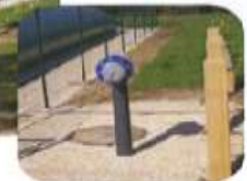
Citerne 120 m 3 aspiration hors gel sortie coudée PVC DN 100
